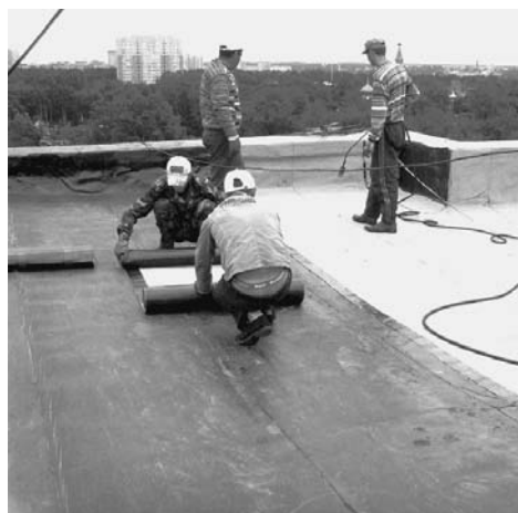
Плановый ремонт кровли
